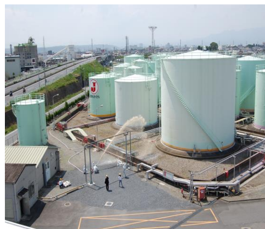
自衛消防隊による泡消火
